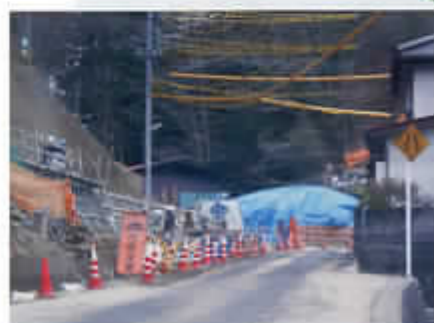
県道笛吹市川三珠線の改良工事
