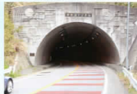
暗く感じる割石トンネル
