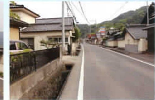
側溝整備が待たれる大同地区
