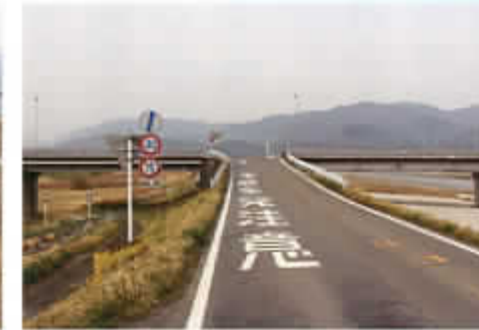
事故が多い三郡橋交差点
