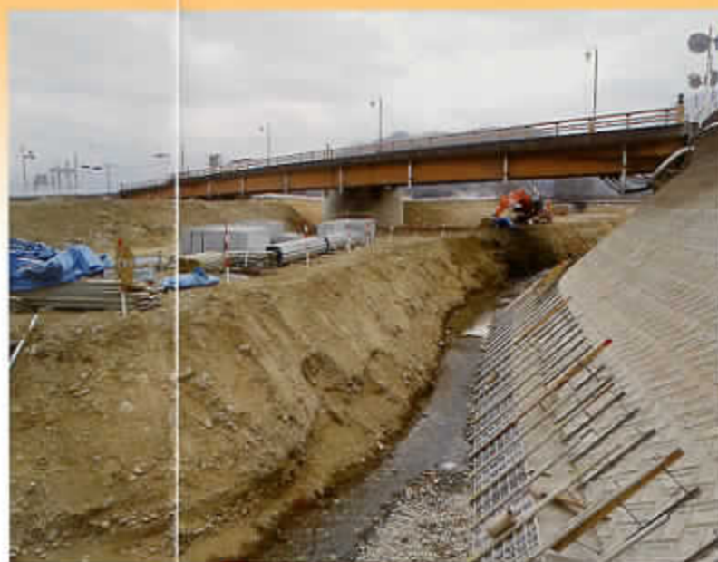
●青洲橋付近の工事の様子。(平成26年)
