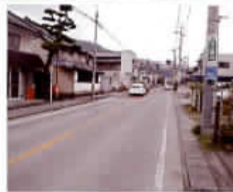
改修工事が待たれる岩間地内
