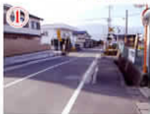
歩道の設置工事が待たれる芦川踏切(上野地内)
