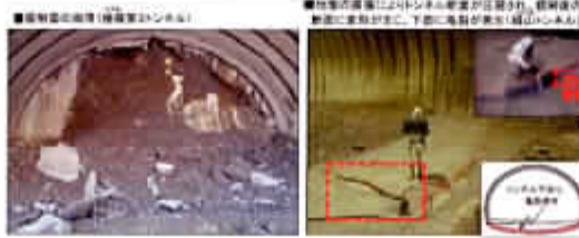
トンネル掘削中の湧水の発生
