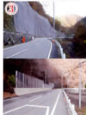
落石防止に対応している防災工事 (堀熊付近)
