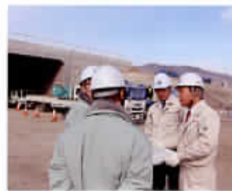
六郷インター工事のようす (平成28年12月)
