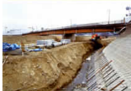
●青洲橋付近の根継ぎ工法工事のようす。(平成27年2月)
