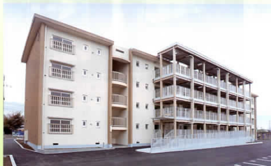
●改修工事が終了した県営三珠団地1号棟
