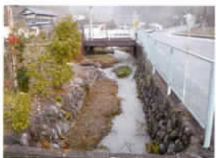
●宮原川、上流未整備箇所。
