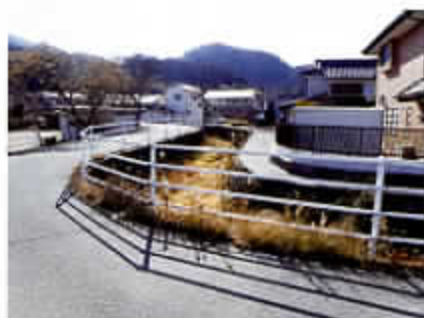
●鳴沢川、印沢地区付近。
