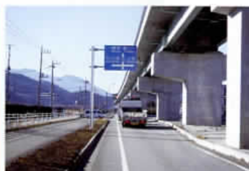
●交通案内表示板が設置された甲西バイパス今泉付近。
