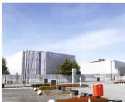
解体工事が始まった新設高校予定地
