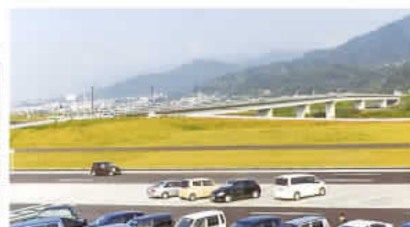
平成29年度補正予算と新年度予算で大きく耐震補強工事が進捗する富士川大橋
